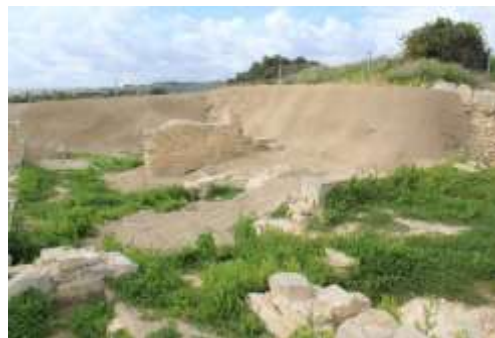
Figure 45 : consolidation des bermes de la fouille du Palais, Amathonte
