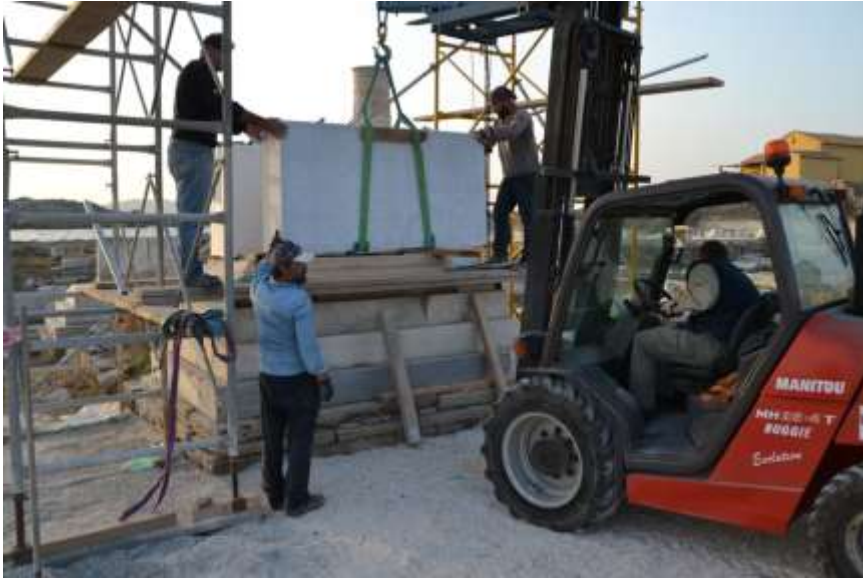
Figure 47 : Délos, restauration du monument de Ménodoros (avril 2018)
