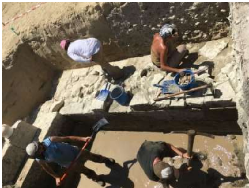
Figure 39 : Amathonte (Chypre), secteur entre le port et l'agora, mur monumental
