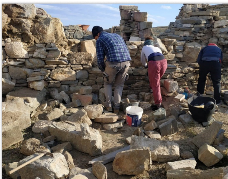
Travaux de restauration, EFA-Fondation Kaplan ©EFA
