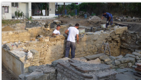
Les maçons au travail : consolidation du refend MUR196 entre PCE55 et PCE20 ©EFA, A. Muller
