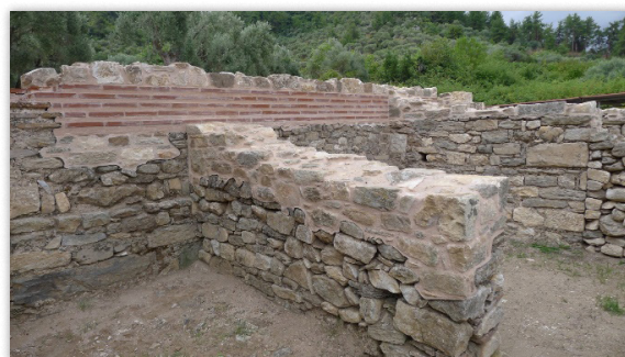
Le MUR18 avec l'arase de briques reconstruite ©EFA, A. Muller
